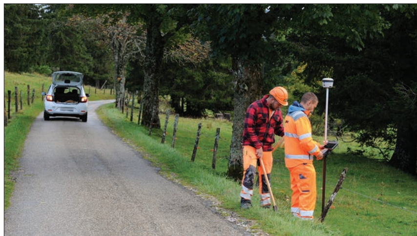
Les travaux préparatoires sont en cours. Ici mardi matin entre la Gittaz-Dessous et la Gittaz-Dessus.
